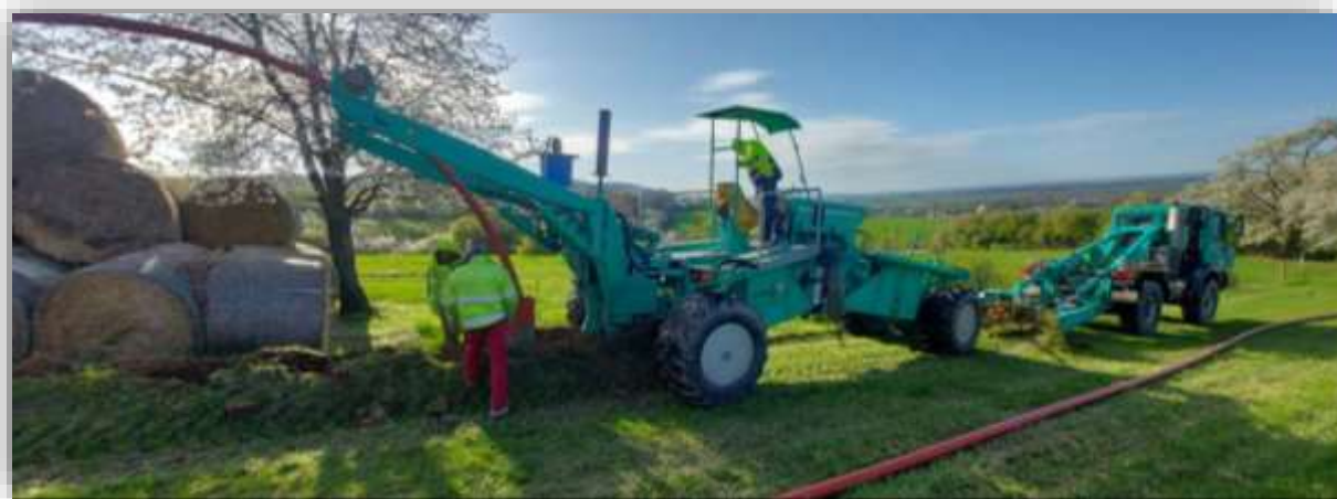
Obrázek 4, 4a: Schéma a ukázka použití metody „Bezvýkopová pokládka pluhováním“.
